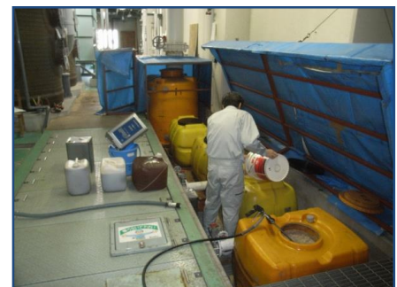
屎尿処理場用EM活性液の作成
