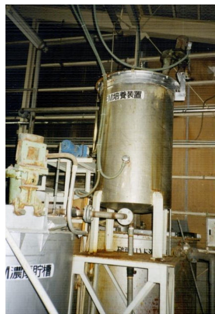
EM活性装置とEM貯留槽
